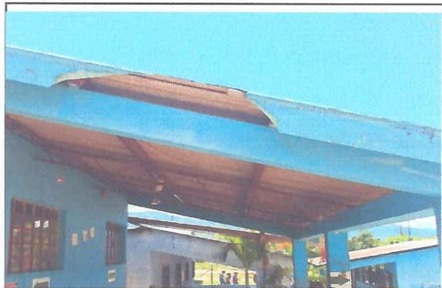
Foto 4: Se puede visualizar el deterioro causado en el material del techado, producto del tiempo de antigüedad.
