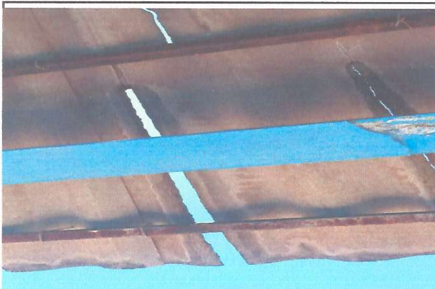
Foto 3: Se puede observar el estado actual de la duralita que cubre los salones de clases.
